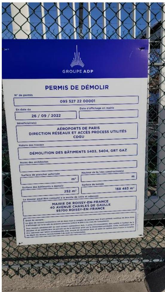
Permis de démolir des bâtiments sur le site de la CTFE à proximité du futur bâtiment d'exploitation
