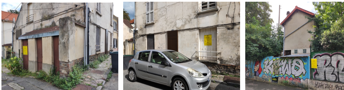
Affiches figurant à l'entrée de l'îlot rue du Chaussy
