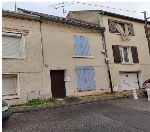
Rue du Chaussy maisons à acquérir en limite de la DUP
